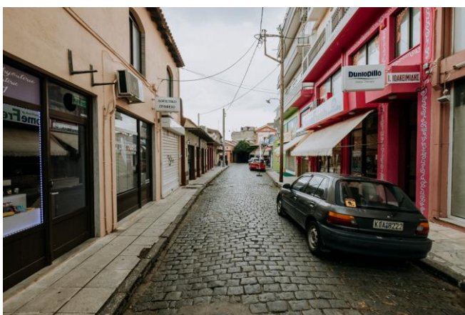
Φωτ. 3 - οδός Κανάρη- εμπορικά καταστήματα (πηγή φωτογραφιών -αρχείο του Δ. Κομοτηνής)
